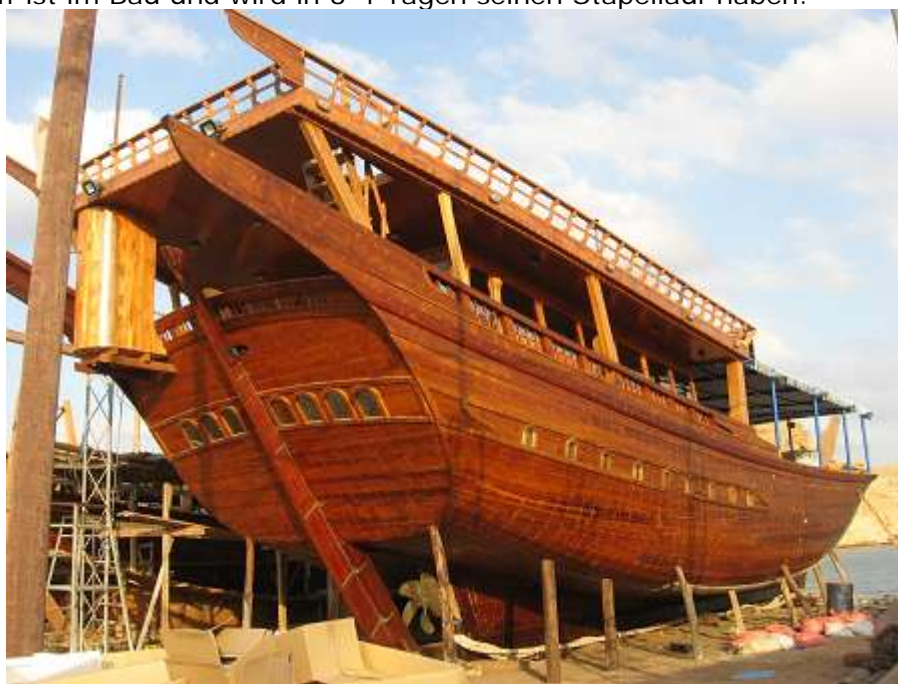
Die neue Dhau, kurz vor der Fertigstellung. Hinten links die Toilette.
