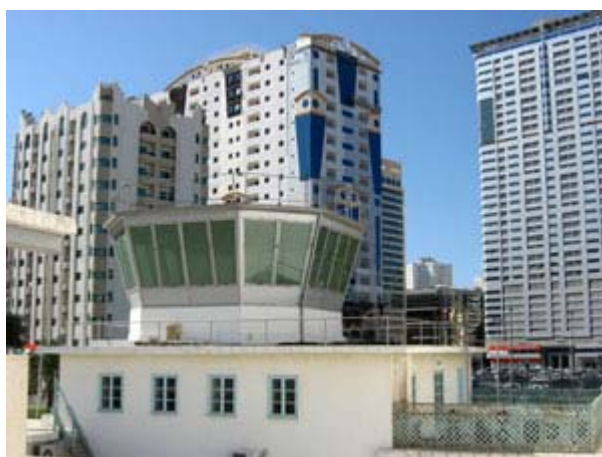
Der alte Kontrollturm in Sharjah
